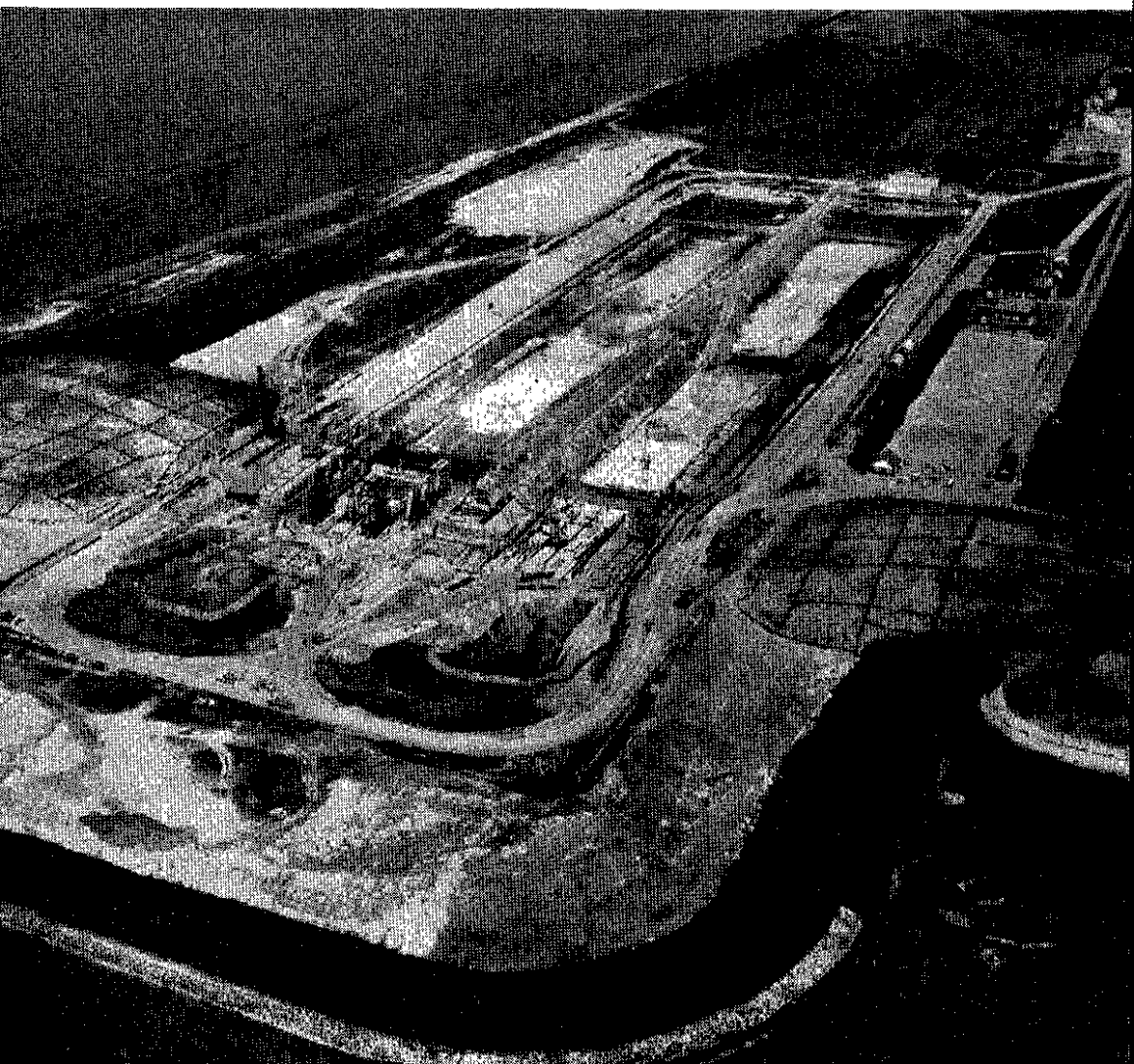
De bouw van de schutsluizen in het Volkerak. Op de achtergrond de noordelijke voorhaven
